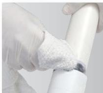
Con un trapo, elimine el exceso de cemento de la tubería y el conector. Este cordón o exceso de cemento no es necesario y no brindará resistencia adicional a la unión, además de extender el tiempo de secado y curado.
