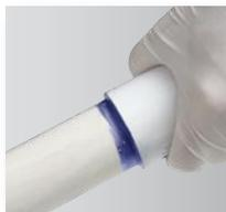
Presione la tubería contra el conector durante al menos 30 segundos para evitar que se muevan o se separen.
